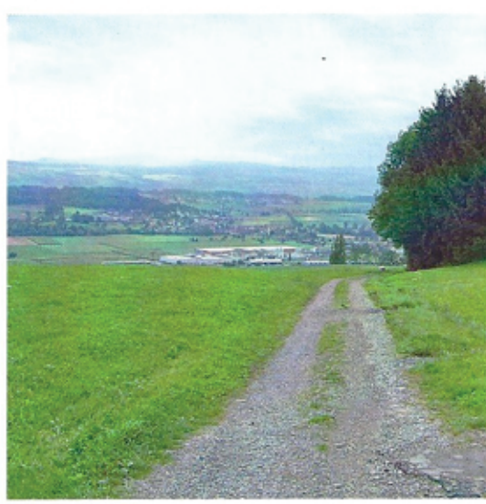
Dieser Wanderweg mit Naturbelag wurde zu einem betonierten Fahrweg ausgebaut.
